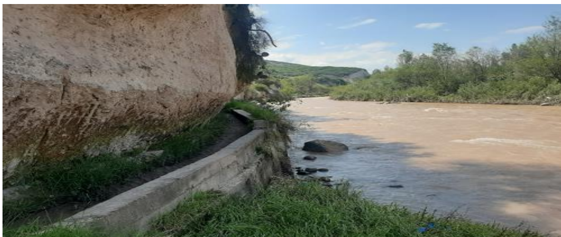
FIGURA N°01: TRAMO CRÍTICO EN EL RÍO OCOPA (RÍO PONGORA), EN EL SECTOR YACUCUICA, CANAL DE RIEGO EN RIESGO
